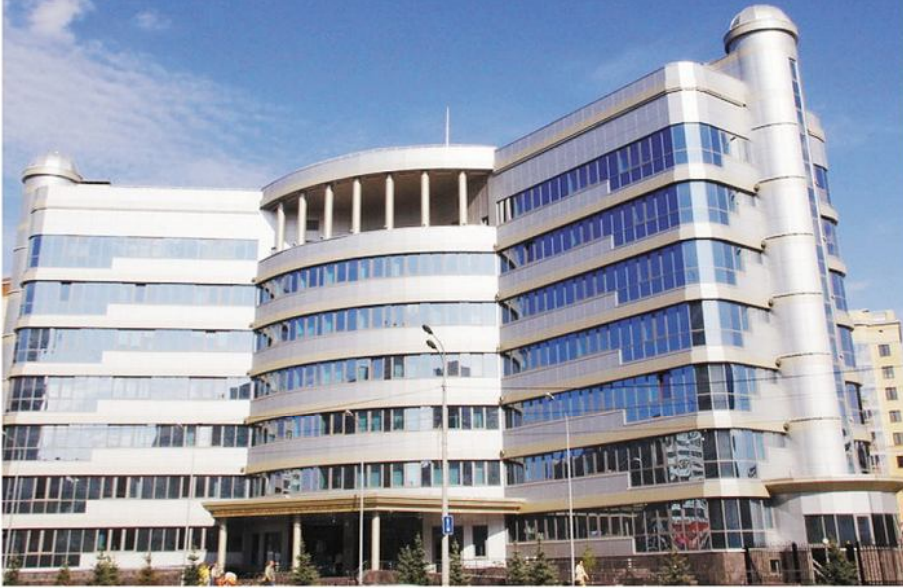
Устройство свайных фундаментов здания Управления федерального казначейства по ул. Вишневского в Казани
