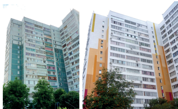
Строительный контроль. Капитальный ремонт фасада жилого дома 52/18
