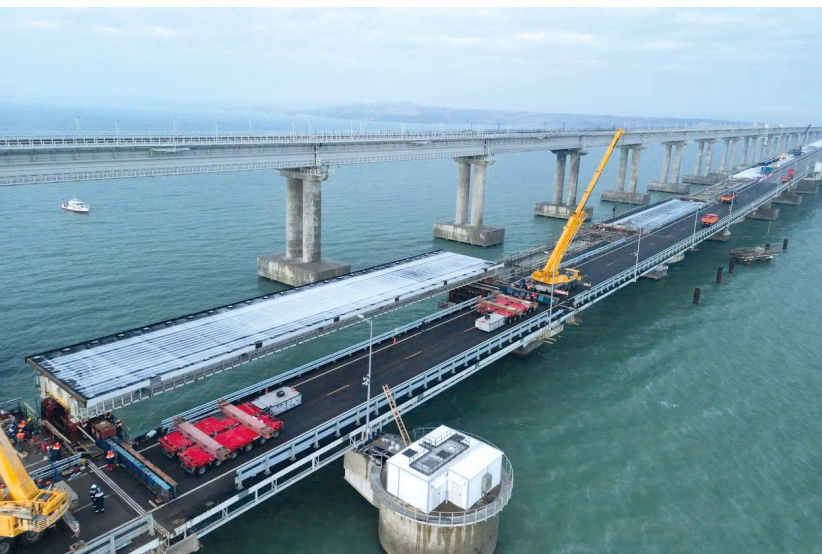
Ремонт Крымского моста, 2022–2023 гг.
