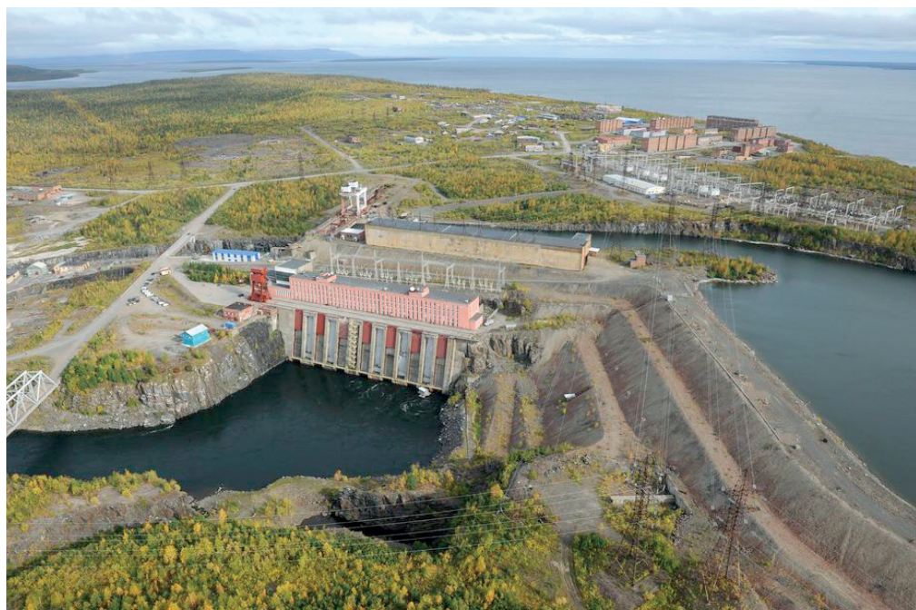
▲ Усть-Хантайская ГЭС. Река Хантайка в Красноярском крае у поселка Снежногорск. Начало строительства: 1963 г. Ввод агрегатов: 1970–1972 гг. Модернизация: 2014–2021 гг.
