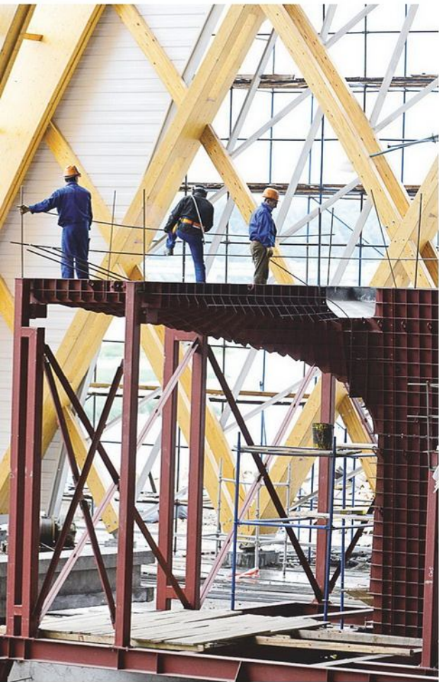
Возведение железобетонных конструкций
