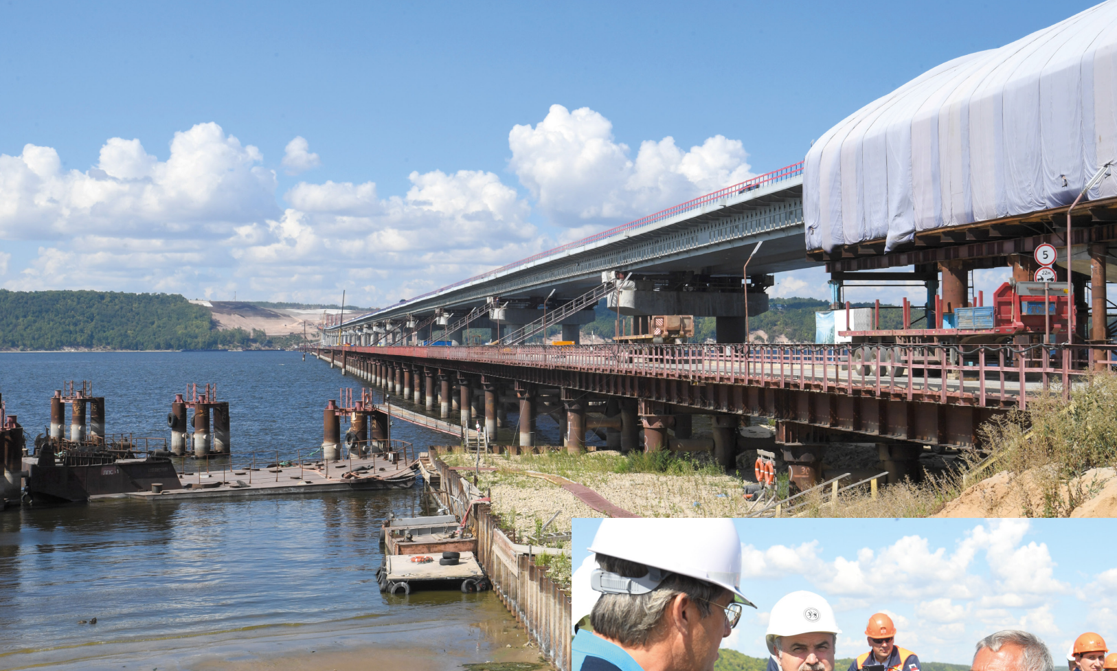
📍 Завершение надвигки пролетов моста через Волгу на М-12
